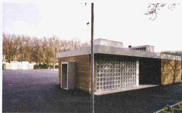
Die zwei Gerätehäuschen Sihlhölzli, 2002. Architekt: Roger Boltshauser; Verfahren: Studienauftrag auf Einladung, 2001; Bauherrschaft: Sportamt der Stadt Zürich.
