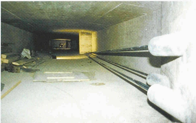
Brücke Verdasio, Verstärkung mit Kohlefasern
