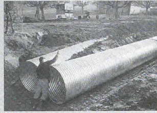
Montage eines HAMCO-Wellstahlrohres in Ermensee, Kt. Luzern.
