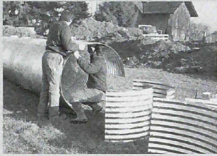
Montage eines HAMCO-Wellstahlrohres in Ermensee, Kt. Luzern.
