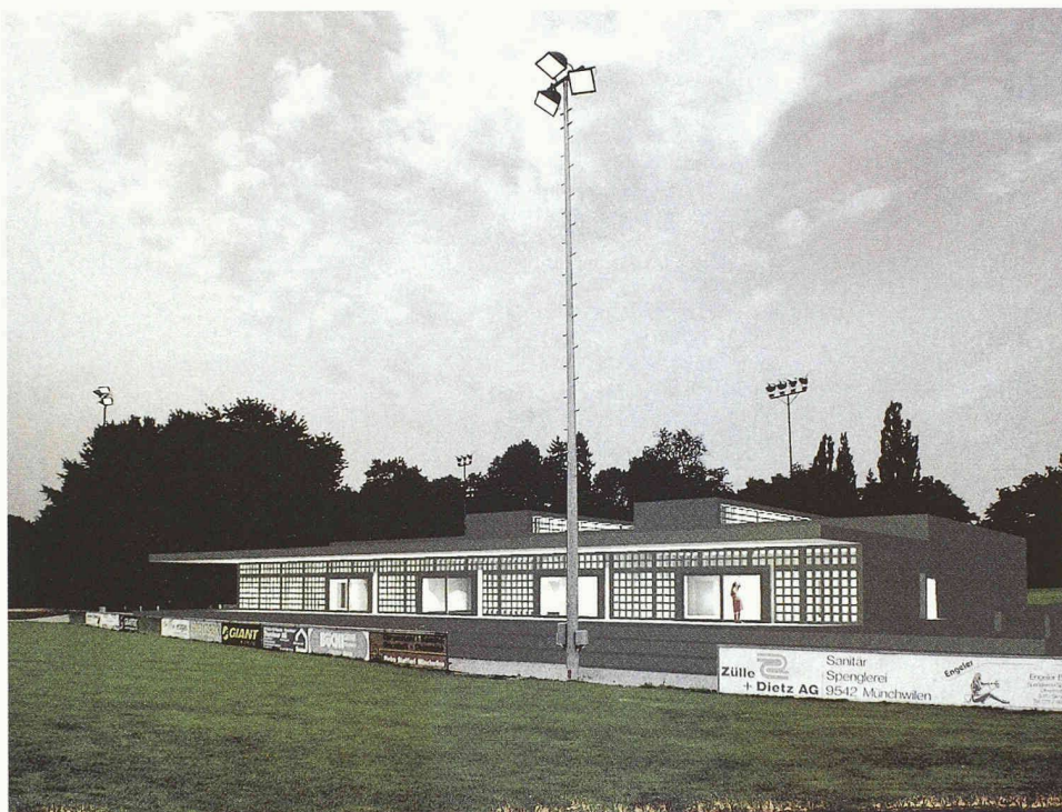
Sporthalle Waldegg, Münchwilen: im Rahmen der Weiterbildung zur Ausführung empfohlenes Projekt von Roger Boltshauser
