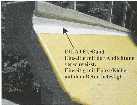
DILATEC-Band als Fugenband beidseitig mit Epoxi-Kleber auf dem Beton befestigt.
