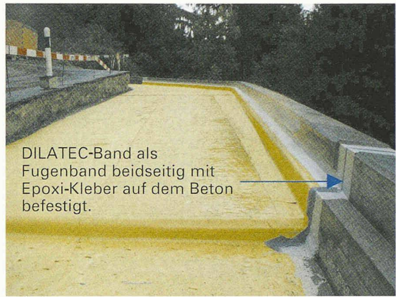
DILATEC-Band Einseitig mit der Abdichtung verschweisst. Einseitig mit Epoxi-Kleber auf dem Beton befestigt.
