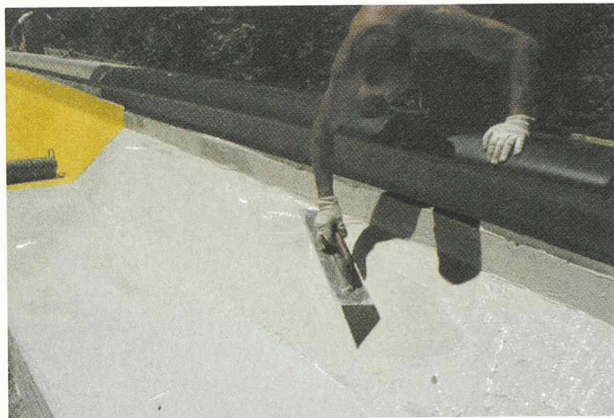
Einbau der vollflächig verklebten PVC-Dichtungsbahn
