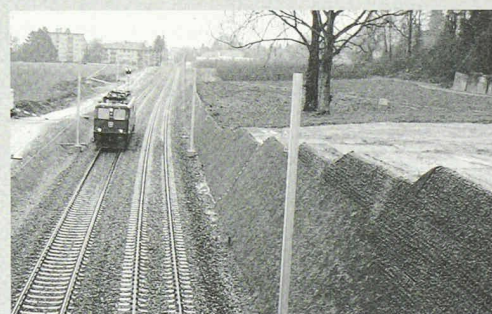
60° Steil- böschung neue Doppelspur MThB Kreuzlingen.
