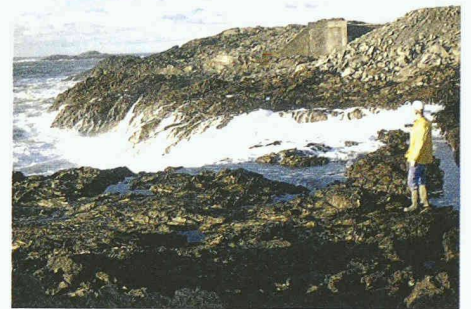
Der Turbinenausgang und die Rückwand des Kollektors (links). Der Limpet passt sich in die Küstenlandschaft ein (oben). (Bilder: Wavegen)
