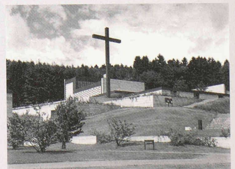
Krematorium Nordheim, 1963–1967. Foto: F. Maurer, Zürich
