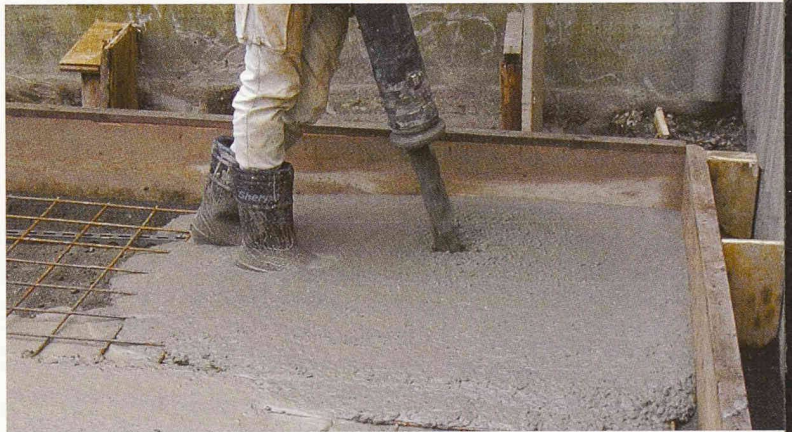
Einpumpen von selbstverdichtendem Beton in ein Fundament
