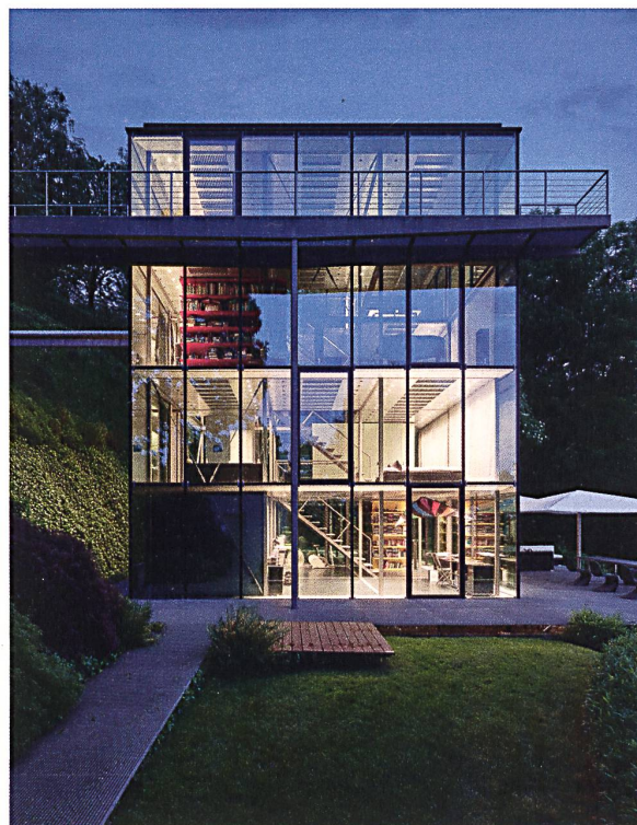
Wohnhaus R128: modularer Aufbau und gesteckte Konstruktionselemente.
