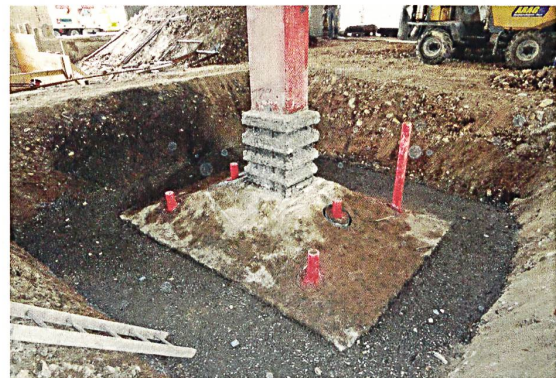
Einzelfundament mit Schubzähnen und durchdringenden, neuen Mikropfählen.
