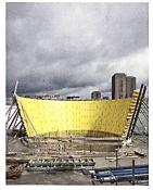
Die Verjüngung und Einfügung des Turmschafts  $\operatorname{in}$  die Rampenanlage. Rechts: zugehörige Schalungsarbeiten.
