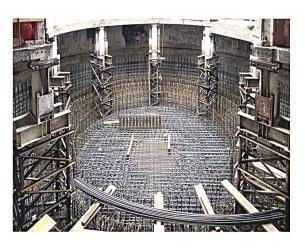
Bewehrungsarbeiten der Turmfundation mit der Abfangkonstruktion der Rampen-Innenstützen (Zeichnung und Foto rechts). Aufgrund beschränkter Zugänglichkeit und Arbeitshöhe liegt der Fundamentkörper auf 140 im Niederdruck-Injektionsverfahren
