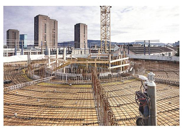
Der Kernbereich mit den Turmschaftwänden überträgt die Lasten des kreisförmigen Wohnzylinders auf die Fundation.
