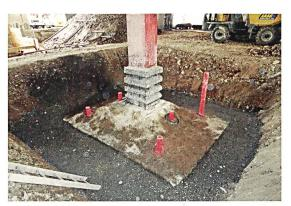
Einzelfundament mit Schubzähnen und durchdringenden, neuen Mikropfählen.
