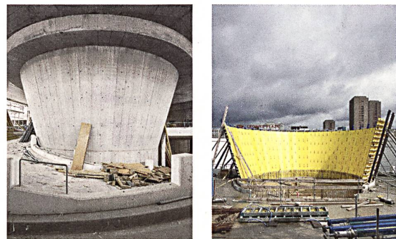
Die Verjüngung und Einfügung des Turmschafts in die Rampenanlage. Rechts: zugehörige Schalungsarbeiten.
