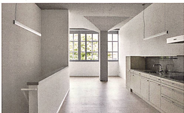
Maisonnetewohnung (oben) und Loftwohnung im Werkstattgebäude: Die Pilzstützen des Altbaus prägen die Identität der Räume. Die alte Fassade wurde samt Betongitter erhalten, die bestehende Verglasung durch neue Fenster ersetzt.
