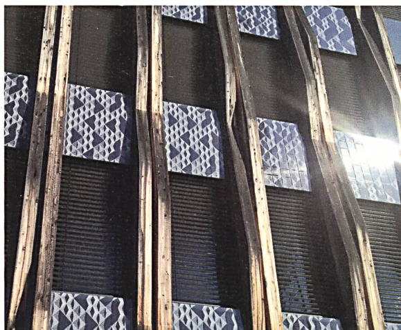
Links: polykristalline Photovoltaikzellen mit grüngoldbraunem Muster an einem Wohnhaus in Zürich (Kämpfen für Architektur); rechts: unterschiedlich gefärbte und angeordnete Zellen an der ConstructPV-Testfassade in Stuttgart (UNStudio).
