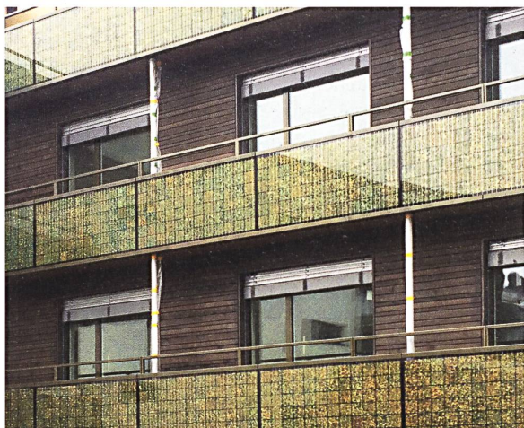
Links: polykristalline Photovoltaikzellen mit grüngoldbraunem Muster an einem Wohnhaus in Zürich (Kämpfen für Architektur); rechts: unterschiedlich gefärbte und angeordnete Zellen an der ConstructPV-Testfassade in Stuttgart (UNStudio).
