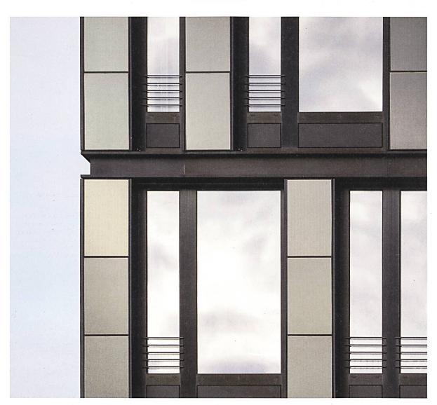
Teilansicht der Südfassade am neuen ZSW-Institutsgebäude in Stuttgart (Architektur: Henning Larsen). Die Dünnschicht-Photovoltaikmodule sind in die opaken Fassadenelemente integriert.
