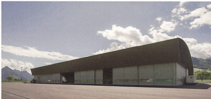
Die Fassaden bestehen teils aus einer Falzblechverkleidung, Fiberglas und Holz als Zahnleistenverkleidung. Die Halle hat einen Betonboden mit weissem Kunstharzbelag. Die 34 m breiten Tore sind dreigeteilt und manuell bedienbar. (cvb)
