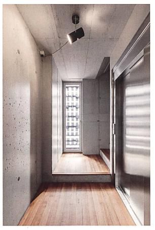
Hauseingang, Korridor und Treppe: Einzelne Photovoltaikpaneele sind ohne rückseitige Folie ausgeführt. Sie dienen als teilweise lichtdurchlässiger Sichtschutz und ermöglichen den Einwohnern einen Blick auf die Solartechnologie des Hauses. Die Holzdielen von Eingang, Korridor und Treppe stammen aus dem Vorgängerbau.
