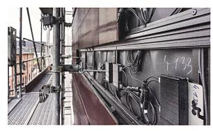
Montage der Photovoltaikhülle: Die Unterkonstruktion und die von aussen unsichtbare Befestigung wurden gemeinsam mit den beteiligten Firmen entwickelt. Jedes Photovoltaikelement ist einzeln demontierbar, was den Unterhalt und allfällige Reparaturen erleichtert. Die offenen Fugen zwischen den Elementen sind 6 mm schmal, Rahmen gibt es keine.
