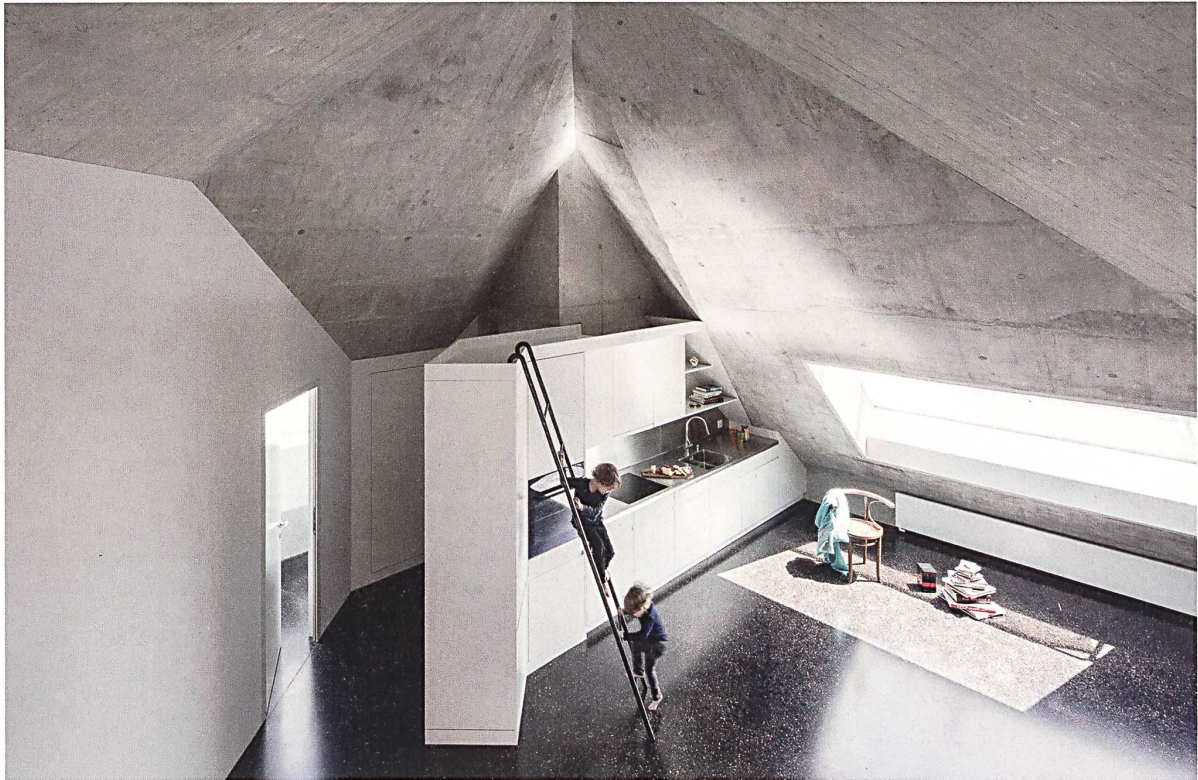
Wohnung im Dachgeschoss: Die tragende Struktur aus Beton ist sichtbar belassen, während die Trennwände weiss gehalten sind. Der Boden ist ein Asphalt-Terrazzo.
