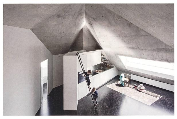
Wohnung im Dachgeschoss: Die tragende Struktur aus Beton ist sichtbar belassen, während die Trennwände weiss gehalten sind. Der Boden ist ein Asphalt-Terrazzo.
