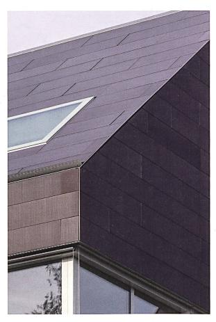
Einfach, aber wirkungsvoll konstruierte Photovoltaikelemente: aussen profiliertes, braun bedrucktes Glas, auf der Innenseite monokristalline Siliziumzellen, die mit einer im Vakuumverfahren angebrachten schwarzen PVP-Folie an das Glas befestigt sind. Die Abschattung der Module durch die Profilierung und das Bedrucken des Glases beträgt nur 15 bis 20%.
