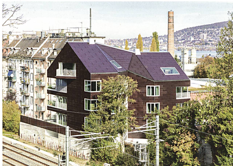
Haus Solaris, Zürich 2017. Unsichtbar mit Photovoltaikzellen hinterlegte Elemente aus profiliertem Gussglas bilden eine All-over-Hülle, die Strom produziert.
