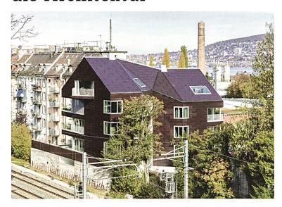
Haus Solaris, Zürich 2017. Unsichtbar mit Photovoltaikzellen hinterlegte Elemente aus profiliertem Gussglas bilden eine All-over-Hülle, die Strom produziert.
