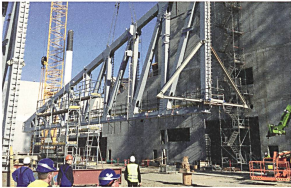
Einhub des ersten Dachbinders mit 90 t.
