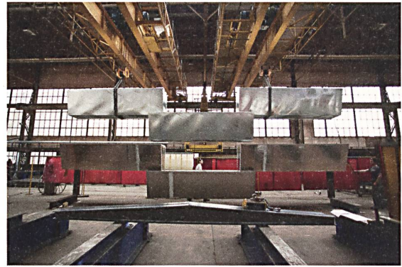
Fertigung von Fassadenelementen in der Produktionshalle von Tuschmid in Frauenfeld.
