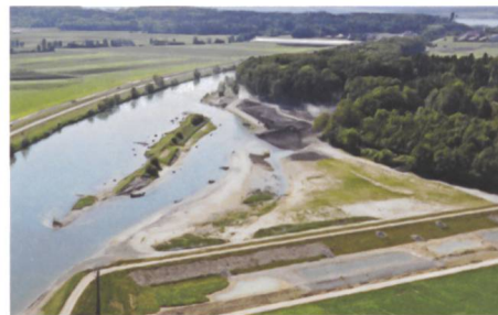
Sanierung Hagneckkanal (Aare), Hagneck BE
