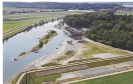
Sanierung Hagneckkanal (Aare), Hagneck BE
