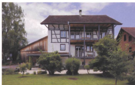
Fassadensanierung ehemaliges Gemeindehaus, Dachsen ZH
