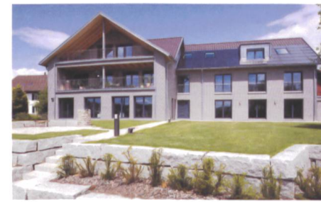
Ersatzneubau in Kernzone, Dachsen ZH
