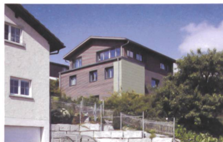
Energetische Modernisierung 1950er-Jahre-Haus, Wetzikon ZH
