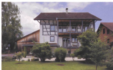
Fassadensanierung ehemaliges Gemeindehaus, Dachsen ZH
