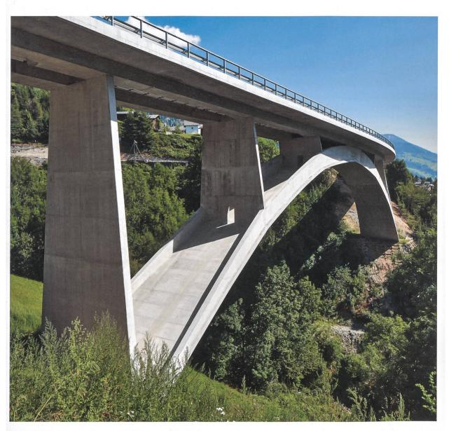
Punt Val Mulinaun in der Surselva: Die Stützen sind für Unterhaltsarbeiten mit einem Durchgang für die Begehung des Bogens versehen. An den Kämpfern ist die Bogennormalkraft weitgehend in der Bogenplatte konzentriert und wird so in die Fundation abgegeben. Am Scheitel werden die Rippenwände über einen Bereich von 10 m mit dem Fahrbahnträger verbunden.
