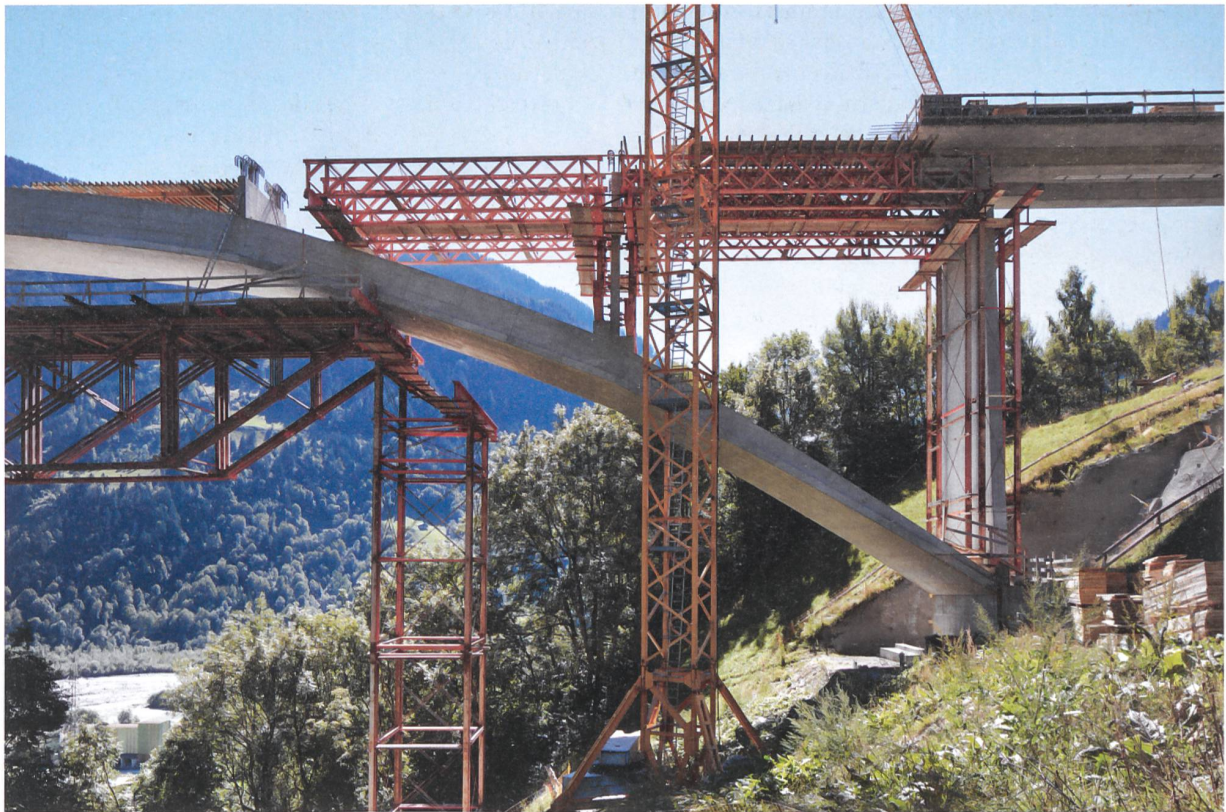
Bauphase der Bogenbrücke mit einfachen Gerüsttürmen und einem verbindenden Fachwerkträger.
