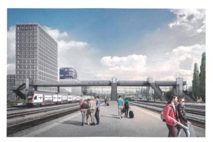
1. Rang: «Tendenza». Die durchgehende Führung des torsionssteifen Trägers – gewunden bei den Treppenanlagen und verbindend über die Brückenfelder – erläutert das Tragverhalten des Gesamtwerks eindrücklich.
