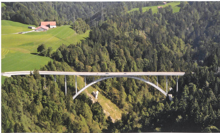
Die Hundwilertobelbrücke zwischen Hundwil und Waldstatt im Kanton Appenzell Ausserrhoden. Die Brücke ist 90 m hoch und 269 m lang und hat eine Spannweite von 143 m. Beim Bau wurde ein neues Verfahren angewendet.
