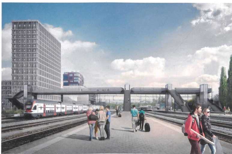
1. Rang: «Tendenza». Die durchgehende Führung des torsionsstifen Trägers – gewunden bei den Treppenanlagen und verbindend über die Brückenfelder – erläutert das Tragverhalten des Gesamtwerks eindrücklich.
