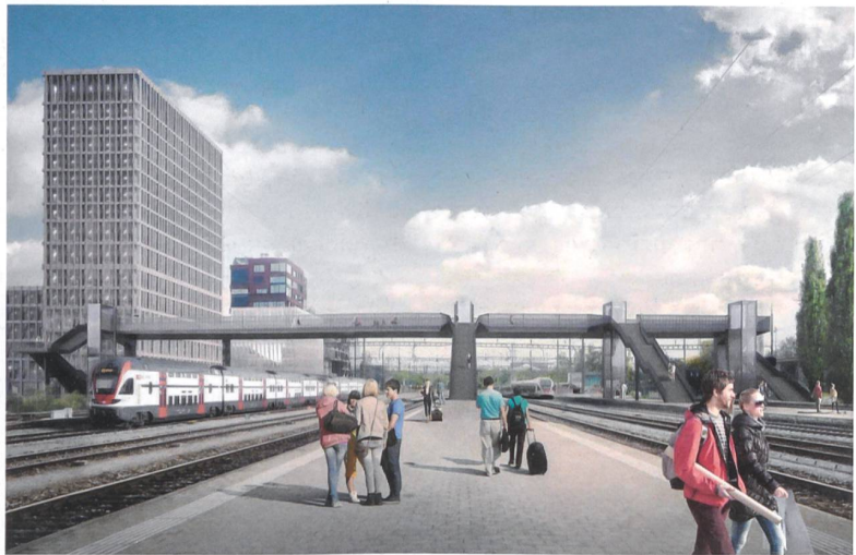
1. Rang: «Tendenza». Die durchgehende Führung des torsionssteifen Trägers – gewunden bei den Treppenanlagen und verbindend über die Brückenfelder – erläutert das Tragverhalten des Gesamtwerks eindrücklich.
