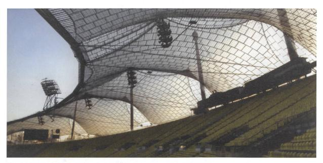
Überdachung der Tribünen des Olympiastadions in München mit Seilnetz und entmaterialisierter Dachhaut aus Acrylpaneelen.
