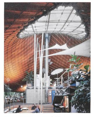
Institut für Leichte Flächentragwerke in Stuttgart: der Architekt Frei Otto **übertrug die Membrantragwirkung des Stoffs auf das Seilnetz aus Stahl**. Die Dachhaut aus Eternit und gedämmter Holzschalung erfüllt nur eine sekundäre Tragfunktion.
