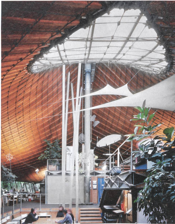
Institut für Leichte Flächentragwerke in Stuttgart: der Architekt Frei Otto übertrug die Membrantragwirkung des Stoffs auf das Seilnetz aus Stahl. Die Dachhaut aus Eternit und gedämmter Holzschalung erfüllt nur eine sekundäre Tragfunktion.
