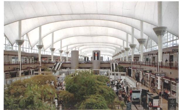
Oben: Die antiklastisch gespannte Membrane in Reinform: Der Pavillon der Bundesgartenschau in Kassel. Darunter: Durch Aneinanderreihung können grosse Flächen überspannt werden, wie beim Flughafen in Denver.
