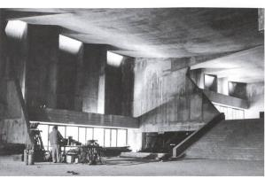
Oben: Provisorisch gefaltet: Überdachung der Kirchenruine in Bad Hersfeld während der Abwicklung der Membran. Darunter: Spannbeton-Hängedach des Stadttheaters Basel mit der Analogie zum gefalteten Baldachin im Bereich der Oblichter.
