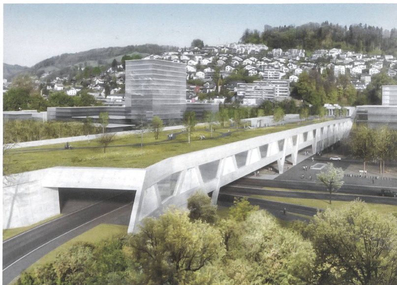
Mit drei Verkehrsebenen – zuoberst ein Park, in der Mitte die Autobahn und unten die Stadtebene – gewinnt «Viva» den Wettbewerb der neuen Grosshofbrücken Kriens.
