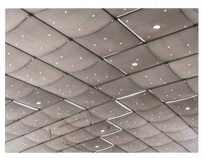
Das Dach des 2014 abgerissenen Metrodome in Minneapolis, einer Traglufthalle.
