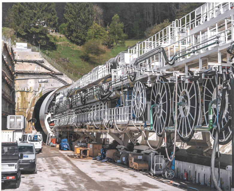
Voreinschnitt Schinznach mit installierter Tunnelbohrmaschine vor dem Portal des neuen Bözbergtunnels. Links die rückverankerte Bohrpfehlwand.
