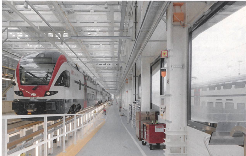
400 m lange Züge können komplett einfahren. Die Hochperrons dienen zur Aufbockung der Züge, um die im Fahrgestell angeordneten Antriebe warten zu können.
