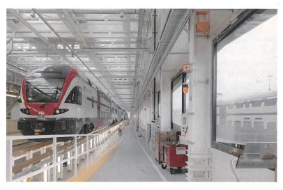
400 m lange Züge können komplett einfahren. Die Hochperrons dienen zur Aufbockung der Züge, um die im Fahrgestell angeordneten Antriebe warten zu können.
