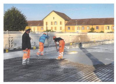
Einbau der 50 mm starken UHFB-Schicht bei der Guillermaux-Brücke in Payerne.
