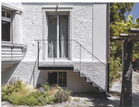
Die neue Treppe stellt die fehlende Verbindung zwischen Haus und Garten her. Dieses zarte Element ist die einzig offensichtliche Veränderung an der Aussenhaut des Hauses.
