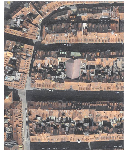
Historische Dachaufsicht mit Capitol in der Bildmitte.
