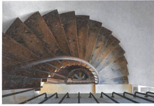
Villa in Rolle: Die Bestandstreppe setzt sich mit einer zugefügten Wendelung hinunter ins neue Gartengeschoss fort. Die Verlängerung interpretiert die Materialien des Bestands, die hier zu einem neuen gestalterischen Ausdruck finden. Coverfoto von Duccio Malagamba .
