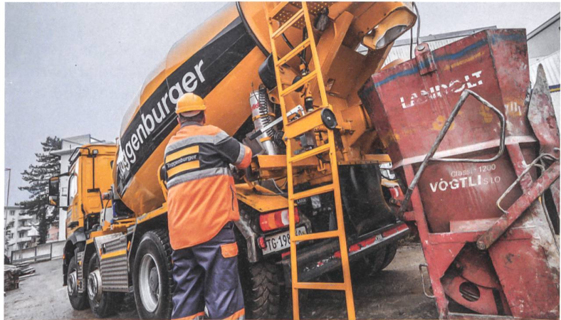
Der flüssige Beton, der aus dem Fahrmischer kommt, ist ein normiertes Produkt. Wasser sollte daher nur gemäss einem dokumentierten Verfahren zugegeben werden.
