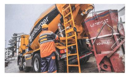
Der flüssige Beton, der aus dem Fahrmischer kommt, ist ein normiertes Produkt. Wasser sollte daher nur gemäss einem dokumentierten Verfahren zugegeben werden.
