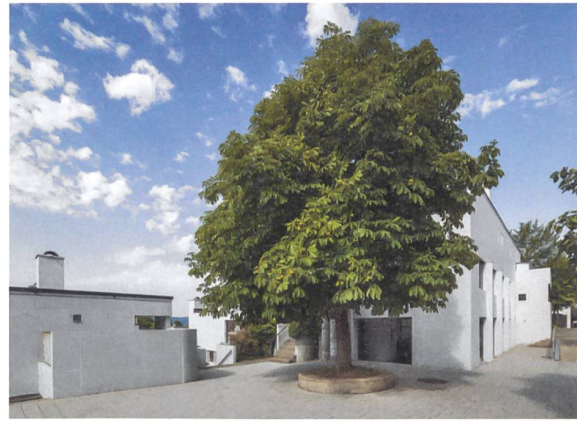
Übergangsbereich Treppenanlage zum Platz mit Eingangsbereichen zu den Wohnungen.
