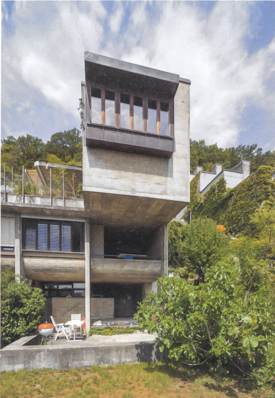
Vorspringender Wohnraumbaukörper an einer Endsituation: Bergender Grund und übermütige, im Leeren hängende Kanzel mit freiem Blick in die Weite.
