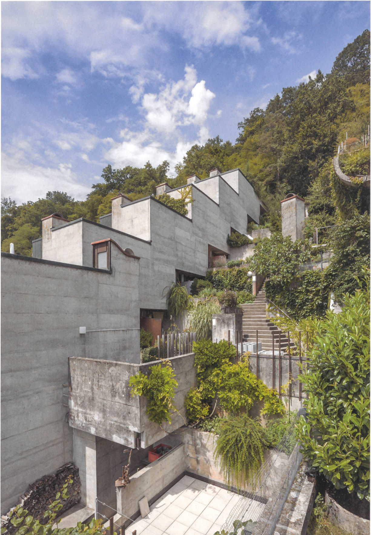
Siedlung Mühlehalde in Umiken, Brugg: Baukörper und Aussenraum sind miteinander verzahnt. Hochbau, Tiefbau und Pflanzungen sind zu einer Einheit verschränkt. Die vertikale Erschliessung wird zum Begegnungsort.
