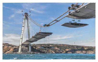
Jean-François Klein, T-engineering intl. (Genf) sind die Erbauer der Bahn- und Strassenbrücke über den Bosporus. Im Bild: Montage der Fahrbahnplatte.
