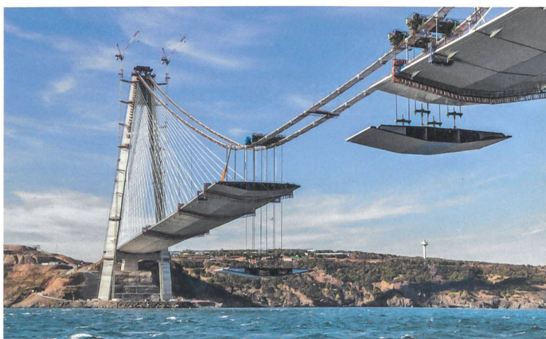
Jean-François Klein, T-engineering intl. (Genf) sind die Erbauer der Bahn- und Strassenbrücke über den Bosphorus . Im Bild: Montage der Fahrbahnplatte.
