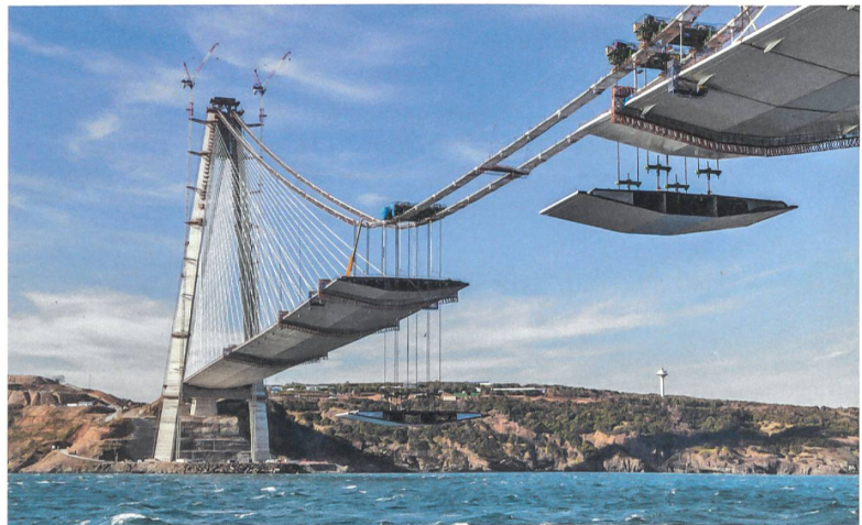
Jean-François Klein, T-engineering intl. (Genf) sind die Erbauer der Bahn- und Strassenbrücke über den Bosporus . Im Bild: Montage der Fahrbahnplatte.
