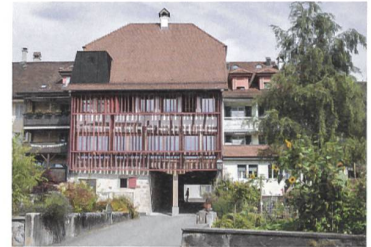
Bestehende Werte klug nutzen: Das spätmittelalterliche Rathaus von 1474 wurde zum Museum umgenutzt. Umbau und Restauration: Gerold Kunz (Konzept), A6 Architekten (Umsetzung).
