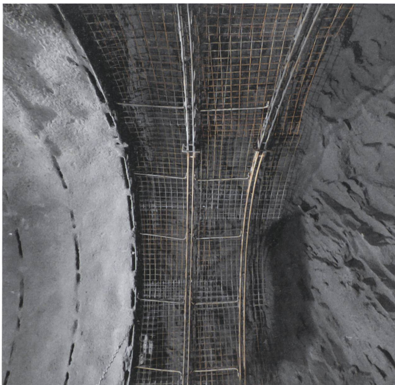
Die Firste an der Ortsbrust des neuen Albula-II-Tunnels auf Seite Preda.
