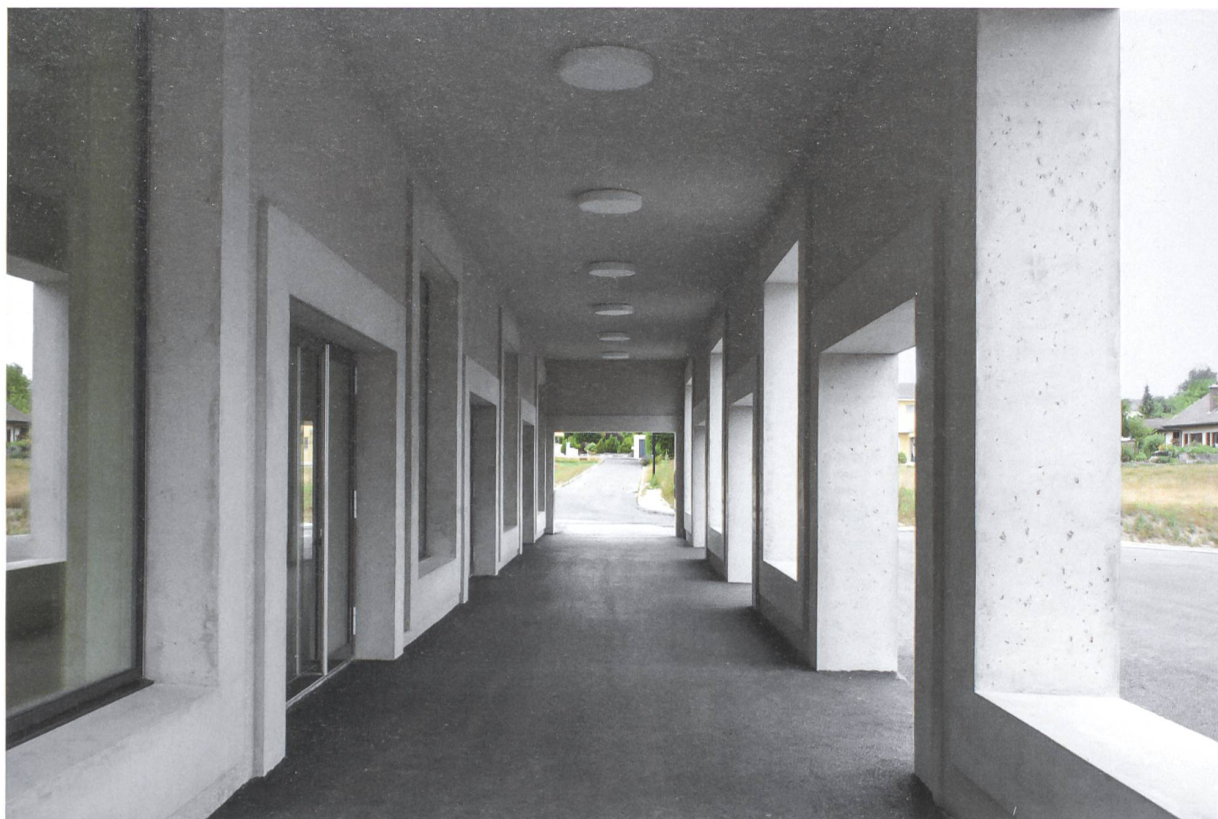
Vor den beiden Eingängen zu Saal und Schule ist die Fassade als Arkade ausgebildet. Der geschützte Aussenraum liegt in der Verlängerung der Strasse, die ins angrenzende Wohngebiet führt. Die analog zu den Fenstern gestalteten Öffnungen können, wie die regulären Fensterbänke, als Sitzgelegenheiten genutzt werden.
