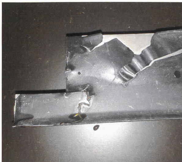
An einem Metallbauteil löst sich die Lackierung.
