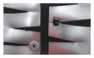
Abgesprengte Befestigungsnieten an Streckmetallfassade: Die Bewegungen des Streckmetalls und die Anzahl der Befestigungen wurden zu wenig beachtet.
