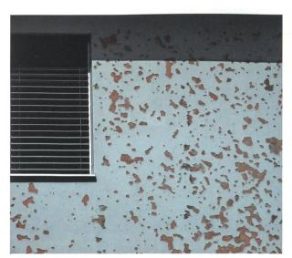
Hagelschäden am Verputz einer Fassade.
