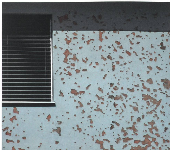
Hagelschäden am Verputz einer Fassade.
