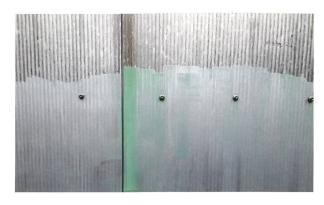
Bei der Reinigung ist nicht nur der Schmutz, sondern auch ein Teil der Lackierung entfernt worden.
