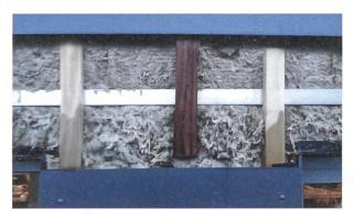
Durchnässte Holzlattung und Wärmedämmung trotz Hinterlüftung: Die EPDM-Fugenbänder wurden nicht gemäss Herstellervorgaben montiert.
