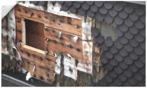
Ein **zu dichter Farbanstrich** auf den Holzschindeln wirkt als Diffusionssperre. Hinter den Holzschindeln staut sich Wasserdampf an und führt zum Faulen des Holzes.
