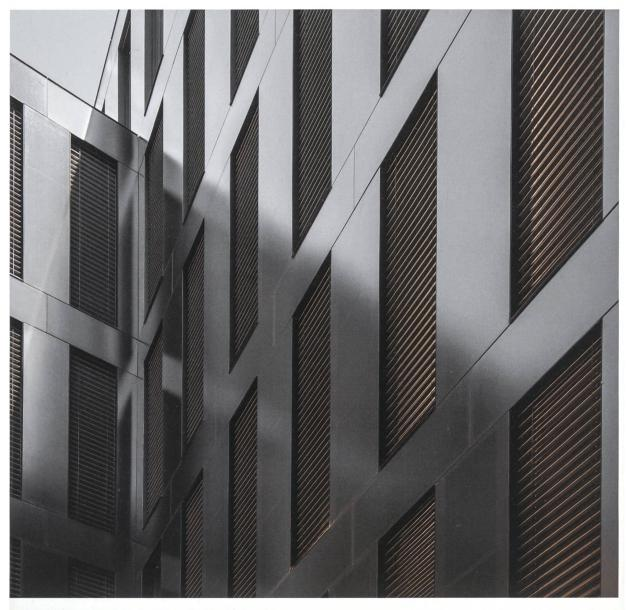
Die Fassadenfläche des Grosspeter Towers von 12000 m² besteht aus transparenten (Dreifach-Isolierverglasung) respektive opaken Elementen. In diese rund **5000 m² grosse opake Fassadenfläche** und auf dem Dach wurden Photovoltaikanlagen angebracht.
