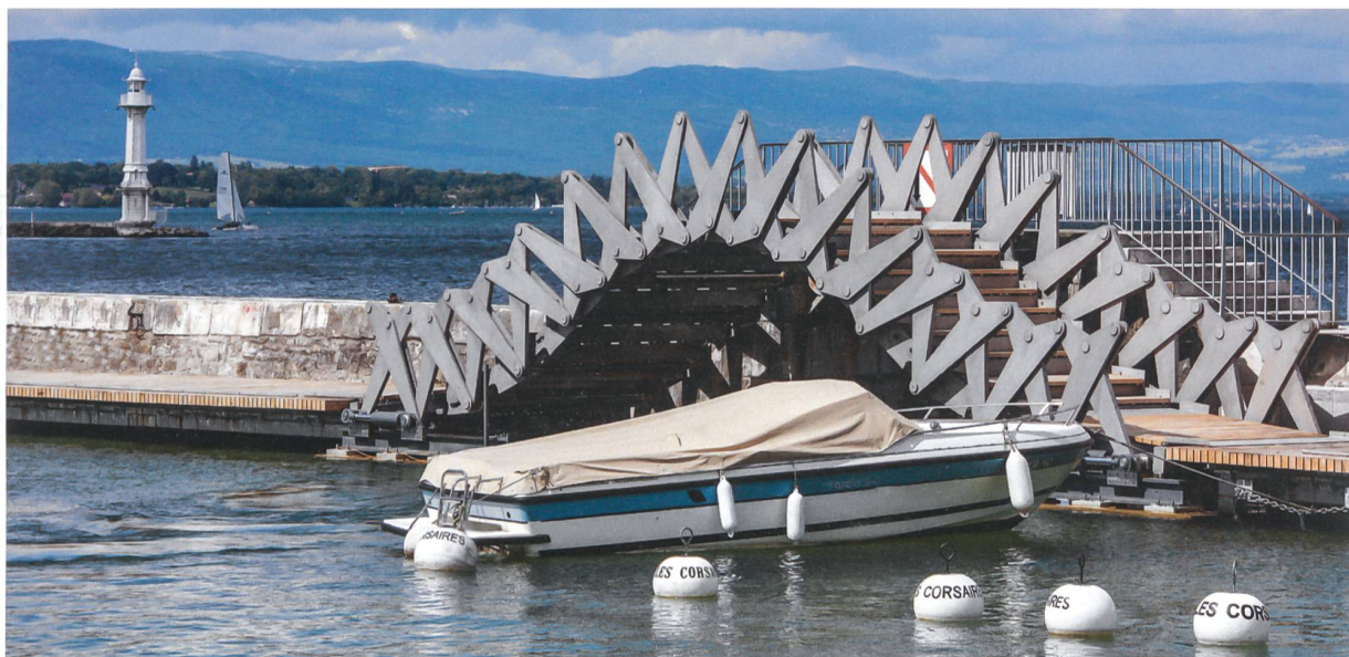
Bei der Mole Eaux-Vives gelangen Besucher über die bewegliche Brücke (im Vordergrund, in angehobener Position) zur Wasserfontäne. Hinter der neuen liegt die historische Brücke.
