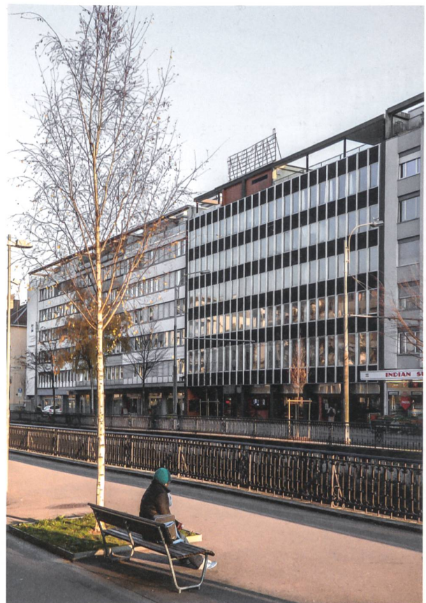
Profile, Aussenplatten und Fenster der Strassenfassade wurden gereinigt, gestrichen und repariert, jene auf der Hofseite gereinigt und repariert.
