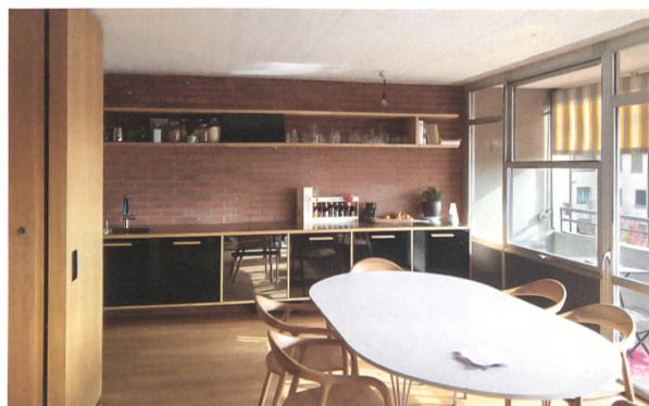
Eine sanierte Wohnung im 1. Obergeschoss, Wohnbereich (links), Küche mit Essbereich (rechts). Die Sichtbacksteinflächen wurden in den originalen Zustand rückgeführt, die Holzböden saniert oder rekonstruiert. Durchgehende Balkone bilden die Fassade zum Hof.
