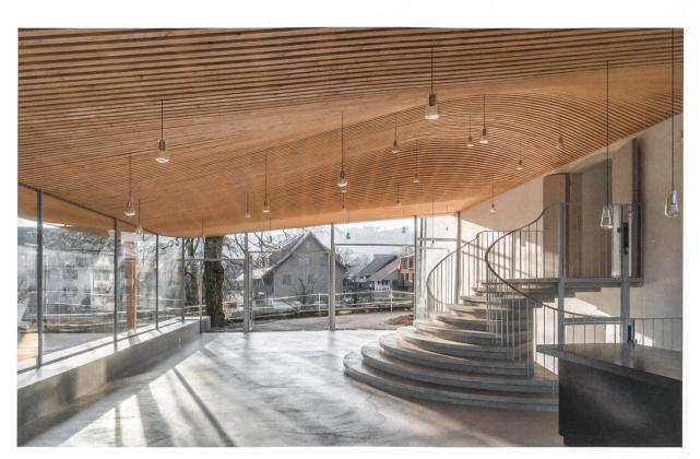
Im Innern wirkt das Foyer offen, und das 9×15 m messende **Dach wölbt sich leicht über den neuen Treppenaufgang aus Mägenwiler Muschelkalk**. Was wie ein leichtes Lattenwerk erscheint ist, in Wirklichkeit die Untersicht des Holztragwerks selber, gebildet aus 46 unterschiedlichen Trägerformen aus Brettschichtholz. Rechts die Holztheke mit Lackierung aus schwarz glänzendem Urushi, an der Decke angehängt die eigens entworfenen, mundgeblasenen Pendelleuchten.
