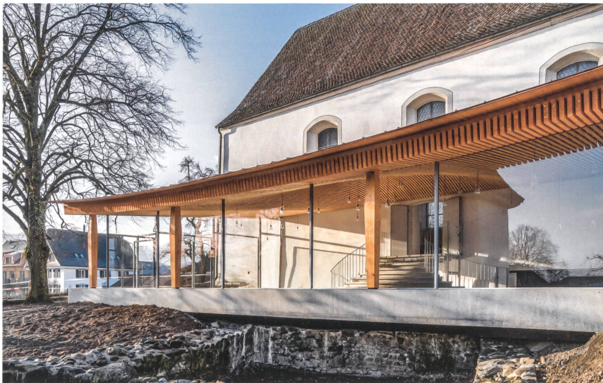
Das neue Foyer ist südseitig angebaut und steht auf einem geschliffenen Betonbalken, der die Ruine aus dem Mittelalter im Garten überbrückt und auch als Sitzbank dient. Die leicht bombierten Stützen aus Brettschichtholz vor der Glasfront tragen den im Dach integrierten Stahlträger für das Auflager der Bohlenbinder.
