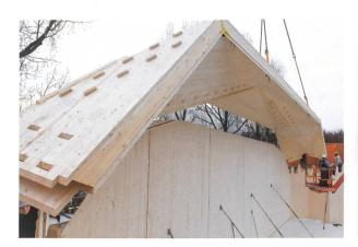
Die Platten sind mit Schwalbenschwanzzinken verbunden und über die vorgegebene Einschubrichtung in ihre Lage gebracht. Doppelzapfen bilden Abstandhalter zwischen den Schichten. In die Öffnungen links wird die Wärmedämmung eingeblasen.
