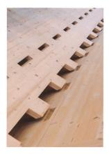
Links: Entlang der gefalteten Kanten sind die Schichten miteinander verbunden. Doppelzapfen sind Abstandshalter. Rechts: Die Zinkenform einer Schwalbenschwanzverbindung erlaubt nur eine Einschubrichtung.
