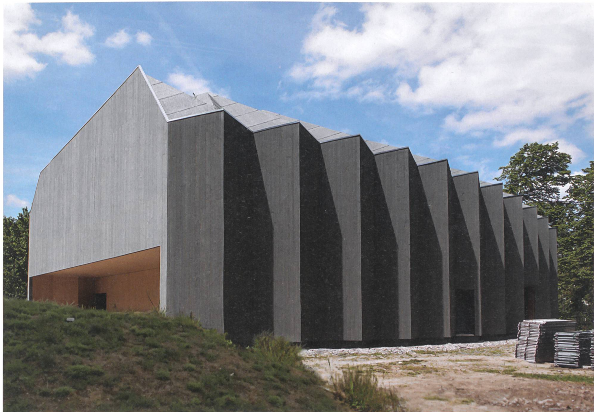
Als Faltwerk konstruierte Binder , zusammengesetzt aus Holzplatten, bilden den 9 m hohen, 28 m langen und 20 m stützenfrei überspannenden Raum des Théâtre de Vidy .
