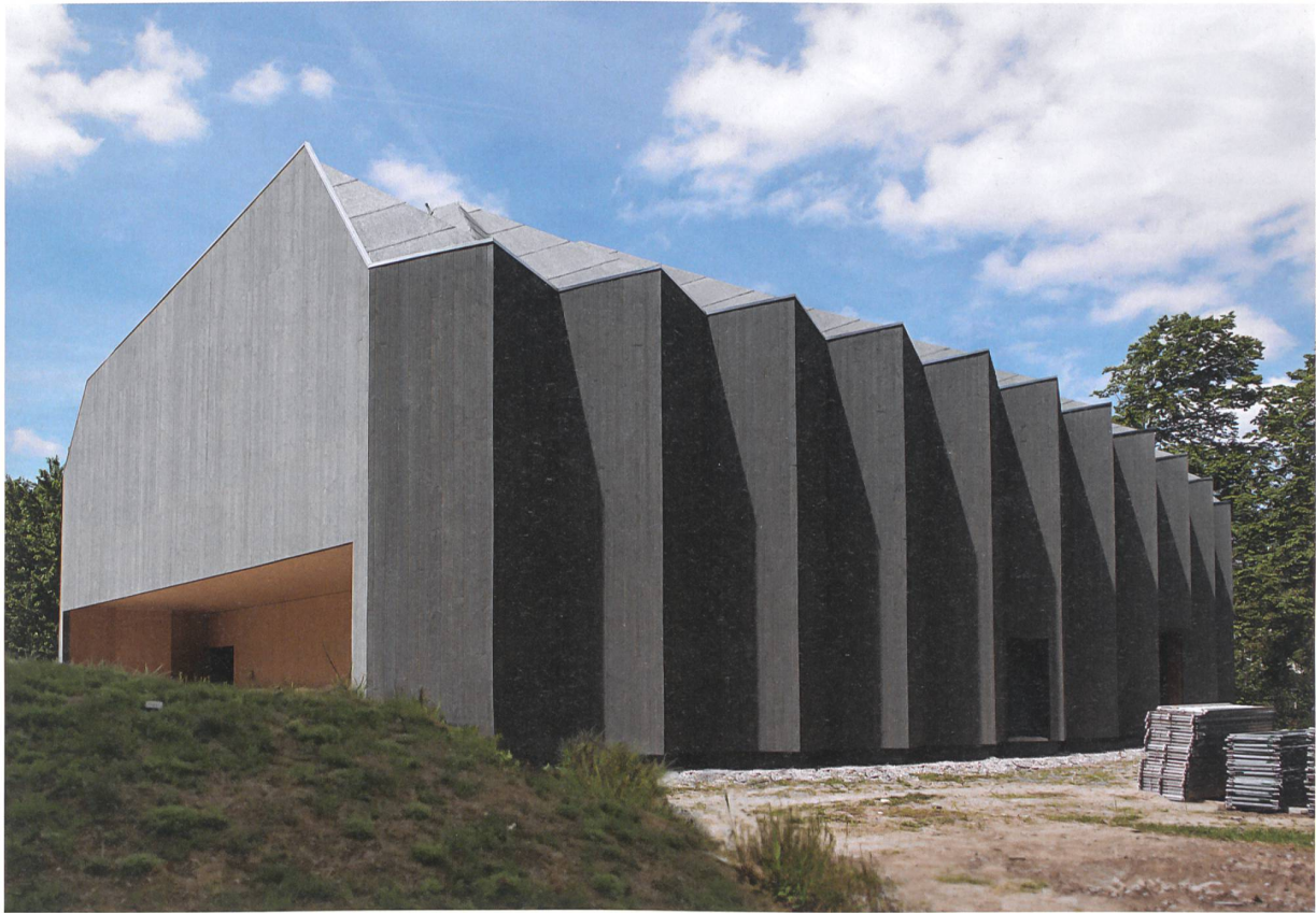
Als Faltnetz konstruierte Binder, zusammengesetzt aus Holzplatten, bilden den 9 m hohen, 28 m langen und 20 m stützenfrei überspannenden Raum des Théâtre de Vidy.
