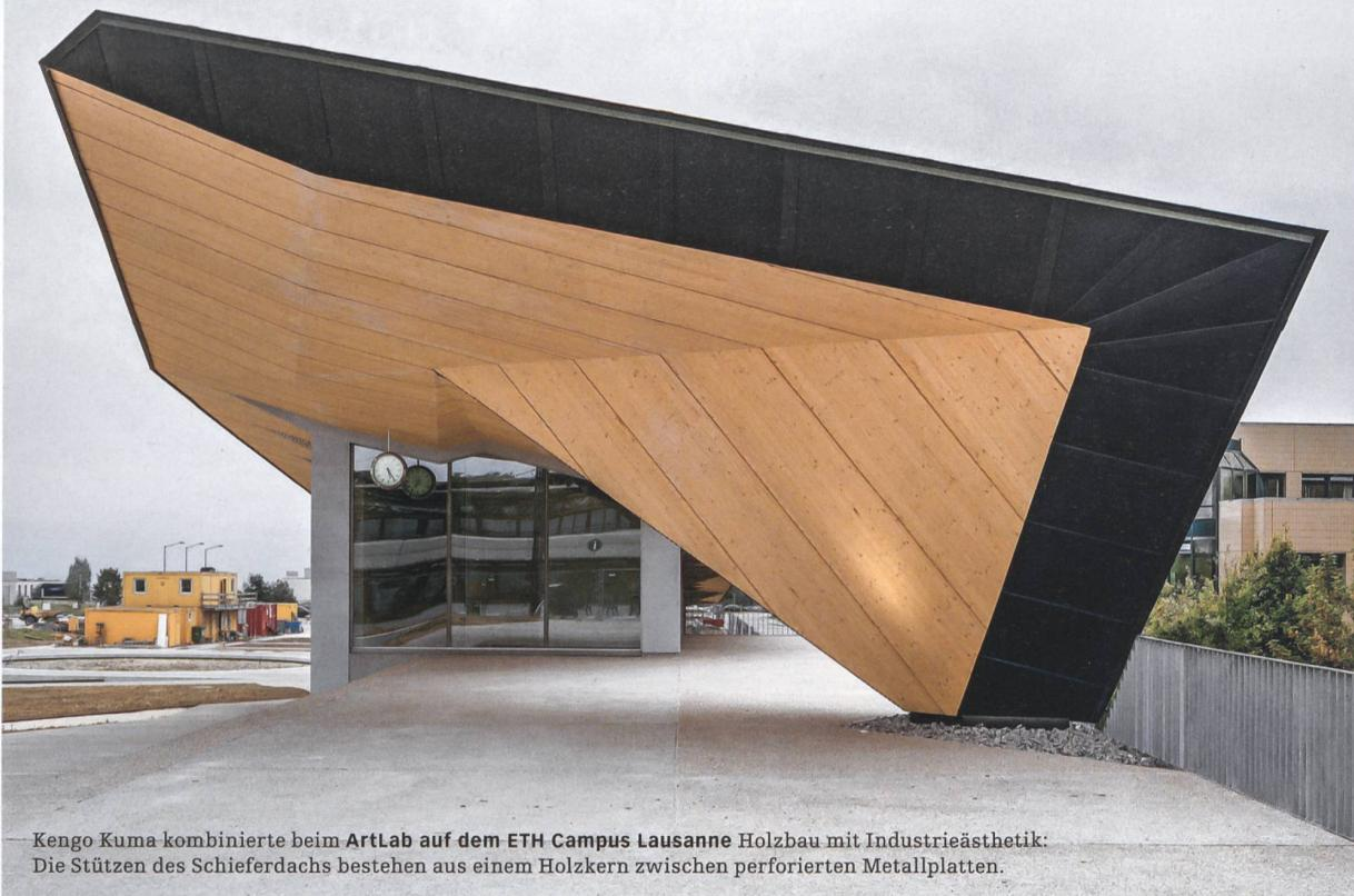
Kengo Kuma kombinierte beim **ArtLab auf dem ETH Campus Lausanne** Holzbau mit Industrieästhetik: Die Stützen des Schieferdachs bestehen aus einem Holzkern zwischen perforierten Metallplatten.
