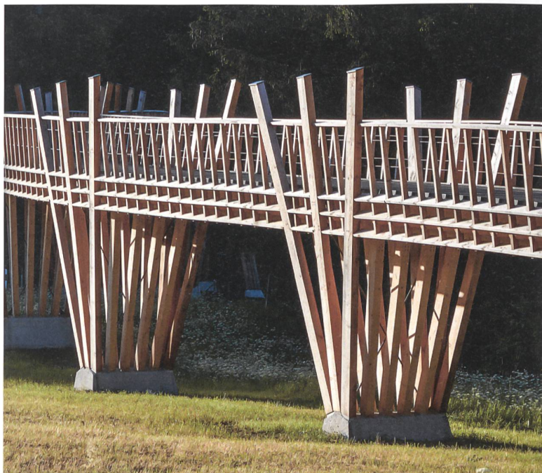
Blick auf das Sprengwerk mit seinen in Längsrichtung gefächerten Pfostenreihen.
