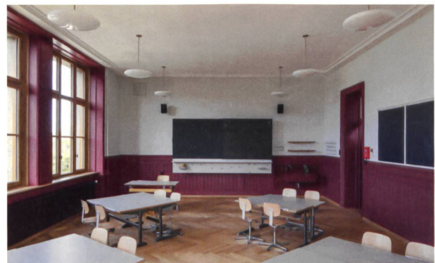
Klassenzimmer nach der Sanierung: Alle Fenster (von 1975, aus Nadelholz) wurden durch neue Eichenholzfenster mit Dreifachverglasung in historischer Teilung und Profilierung ersetzt. Bei den Schränken reparierte man weitgehend den noch brauchbaren Bestand, Ersatzschränke entsprechen im Ausdruck den Originalen. Gläserne Pendelleuchten ergänzen die natürliche Beleuchtung.
