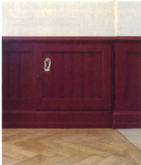
Die Feuerlöscher konnten in Wandnischen hinter den Lamperien untergebracht werden.
