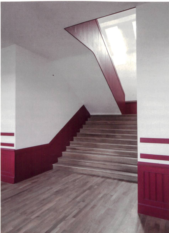
Aufgang vom 3. OG ins DG. Die neue Treppe befindet sich an der gleichen Position wie die Eingangstreppe im EG. Die Stufen im unteren Teil können zum Sitzen genutzt werden. Die Lamperien des Altbaus wurden an den neuen Wänden weitergezogen, sind hier aber flächenbündig mit den vergipsten Wänden ausgeführt.
