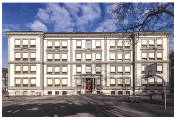
Primarschule St. Johann nach der Gesamtsanierung 2016. Der Dachausbau ist vom Pausenplatz aus lediglich am geschlossenen mittigen Fenster im 3. OG zu erkennen. Ein Fernrohr (vgl. Abb. S. 40) erlaubt den Blick nach draussen.
