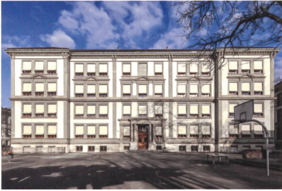
Primarschule St. Johann nach der Gesamtanierung 2016. Der Dachausbau ist vom Pausenplatz aus lediglich am geschlossenen mittigen Fenster im 3. OG zu erkennen. Ein Fernrohr (vgl. Abb. S. 40) erlaubt den Blick nach draussen.
