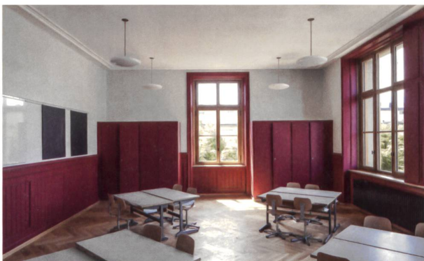
Klassenzimmer nach der Sanierung: Alle Fenster (von 1975, aus Nadelholz) wurden durch neue Eichenholzfenster mit Dreifachverglasung in historischer Teilung und Profilierung ersetzt. Bei den Schränken reparierte man weitgehend den noch brauchbaren Bestand, Ersatzschränke entsprechen im Ausdruck den Originalen. Gläserne Pendelleuchten ergänzen die natürliche Beleuchtung.
