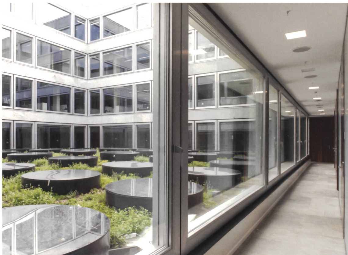
Die innere Lichthoffassade interpretierten die Architekten zugunsten einer höheren Transparenz. Gleichzeitig erhielten die dahinterliegenden Zonen mehr Raum, die Fassade wurde um rund 60 cm in den Innenhof verschoben.
