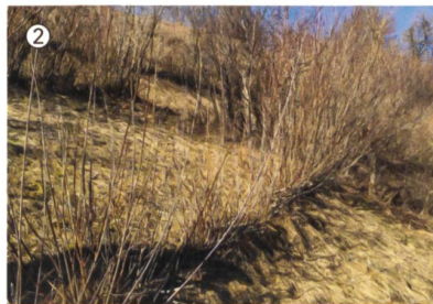
Der Hangrost aus Holz wird zur Verhinderung oberflächlicher Erosion und flachgründiger Rutschung in den Hang eingebracht und mit Grauerle ( Alnus incana ) bepflanzt.
