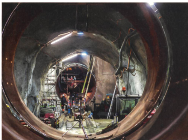
Einbau der Stahlpanzerung in die Oberwasserdruckschächte.
