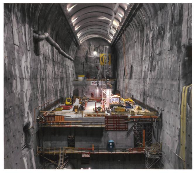
Schnitt durch die Maschinen- und Transformatorenkaverne (ganz oben) und Einbau der Betonbauten zur Aufnahme der Maschinengruppen in die ausgebrochene Maschinenkaverne (darunter). Die Auskleidung der Kalotte (Decke) ist bereits definitiv.
