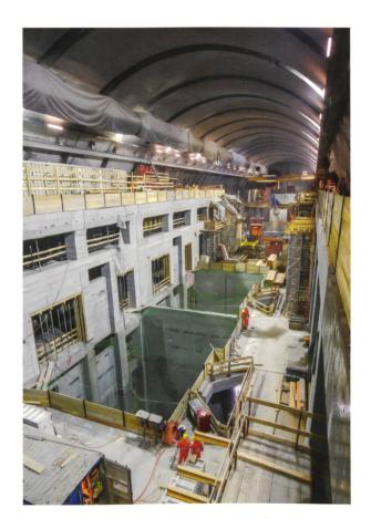
Die **Betoneinbauten der Maschinenkaverne** mit zwei der vier Schächte zur Aufnahme der Maschinengruppen.
