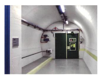
Bei einer Flucht aus dem Haupttunnel gelangt man zunächst in eine Querverbindung. Diese ist beleuchtet und mit Fluchtwegsignalisierung ausgerüstet. Von der Querverbindung gelangt man in den Fluchtstollen.
