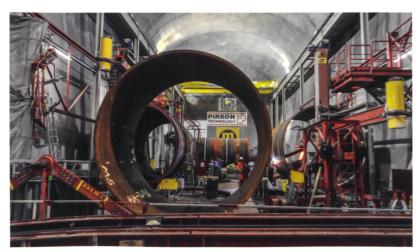
Die 9 m langen **Rohrschüsse** werden in der Schieberkammer auf 2300 m ü. M. aus drei Rohrstücken zusammengeschweisst und in die beiden je 1 km langen Oberwasserdruckschächte abgelassen.
