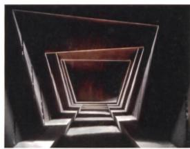
Zur unterirdischen Lagerung und Verkostung von Wein auf einem von RCR konzipierten Weingut gelangt man über ein Gangsystem, dessen Wände aus aneinander gereihten Stahlplatten bestehen.
